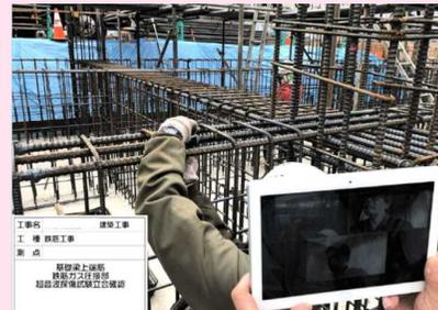
Webカメラを利用した遠隔検査
