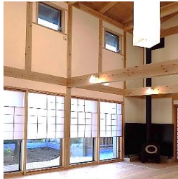
自然通風に配慮した窓
